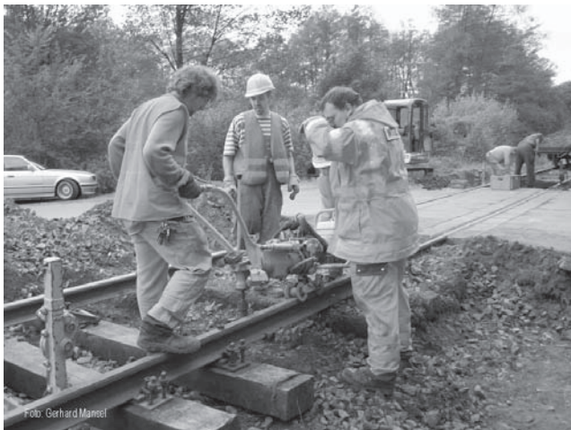
Reparaturtrupp bei der freiwilligen Arbeit
