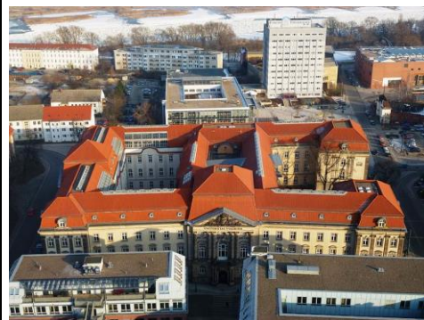
Hauptgebäude der Europa-Universität Viadrina
