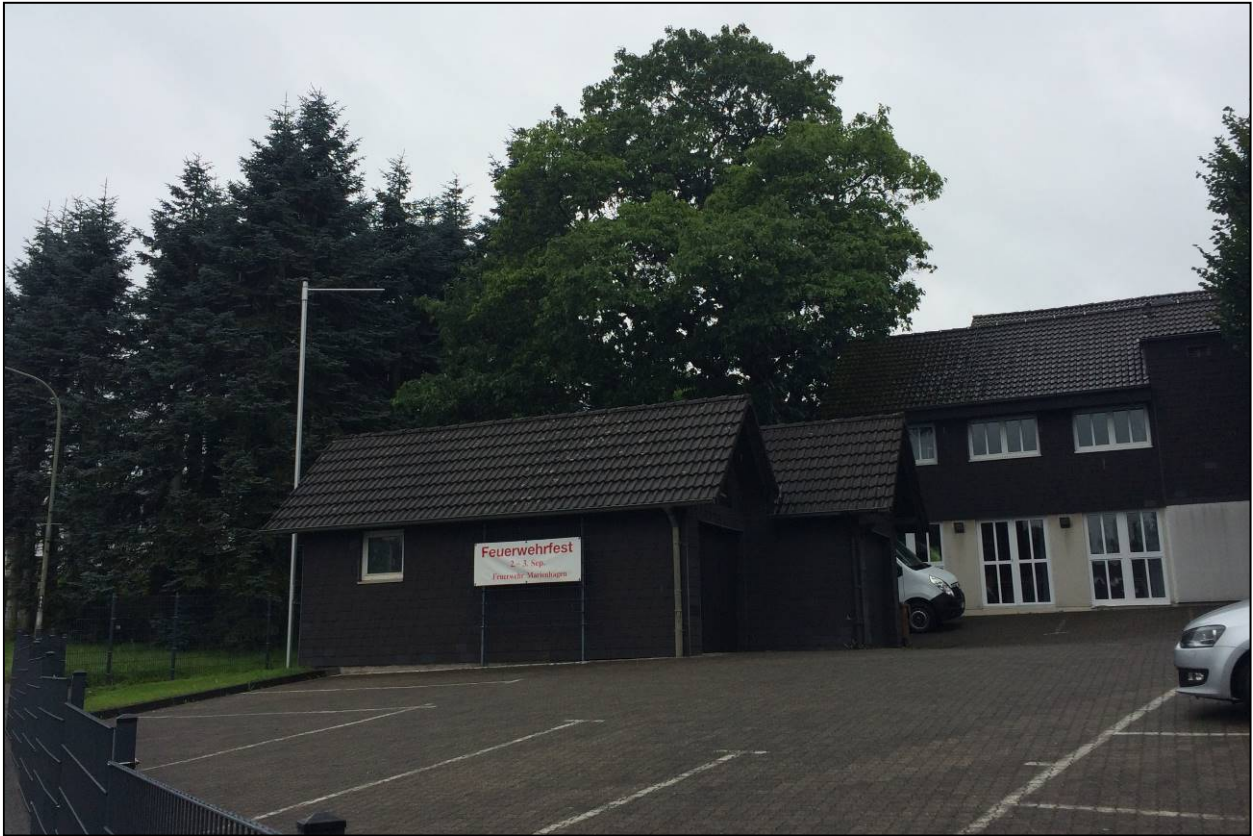
Abb. 2: Parkplatz mit Gebäudebestand
