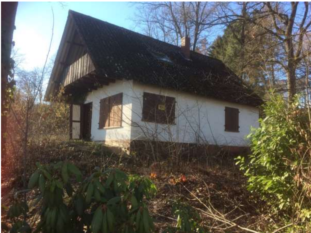
Abb. 2: Bestehendes Haus, welches abgerissen werden soll.
