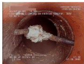
Einragende Dichtung
