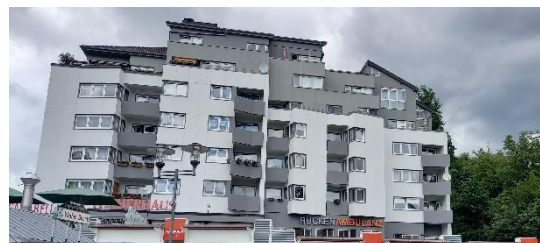
Fertigstellung Foto: Citymanagement Wiehl
