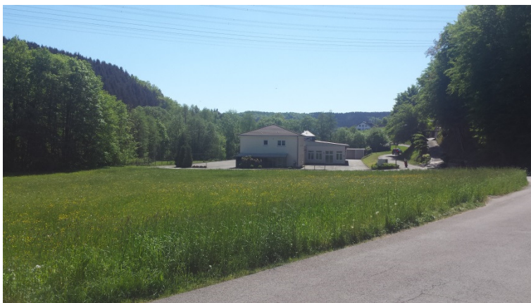
Blick von Norden auf das Gemeindezentrum; Vorbelastung durch Hochspannungsleitung
