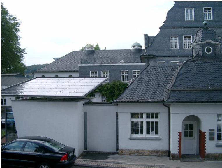
Auf dem modernen Anbau an das neobarocke Pförtnerhaus ist das Photovoltaikdach selbstverständlicher Teil einer gut gestalteten zeitgenössischen Architektur in der unmittelbaren Nachbarschaft des denkmalgeschützten Ensembles. Foto: LVR-ADR
