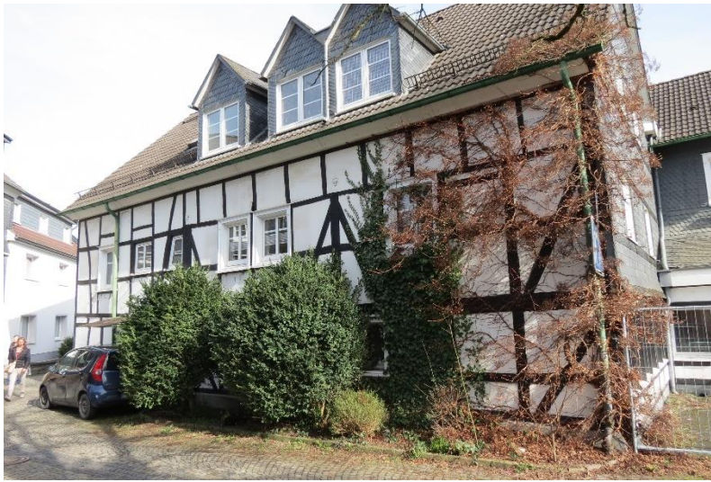
Abbildung 4 bis 6: Plangebiet von der Straße Im Weiher
