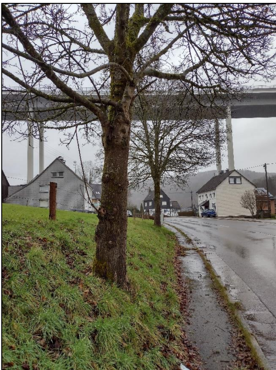
Abbildung 3: Sicht auf die Eiche und den Bergahorn an der Straße L 336 im Osten des Plangebietes.
