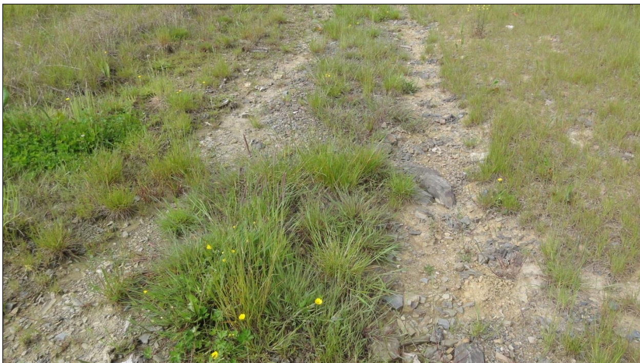
Abb. 3: Geschotterte , ehemalige Bauzufahrt.
